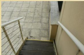
L'escalier extérieur desservant ce bâtiment par des coursives n'est pas conforme (largeur, main courante, nez de marche). La main courante mise en place n'est pas préhensile, un mur en saillie dans l'emprise de l'escalier crée un danger.
