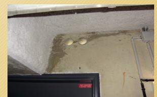
Degré coupe-feu non respecté car deux trous ne sont pas rebouchés. La sécurité incendie n'est pas assurée avec un risque de propagation du feu.
