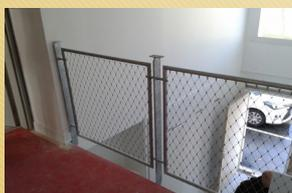
Non-conformité du garde-corps, avec absence de lisse et hauteur inférieure à 1,00 m, ainsi qu'un espace au sol en bas du garde-corps supérieur à 11 cm.
